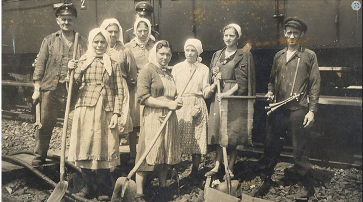
Ukrainische Zwangsarbeiter*innen bei der Ausbesserung zerstörter Gleise für die Reichsbahn an der Bahnlinie Hamburg-Berlin, verm. 1944. © KZ-Gedenkstätte Neuengamme
