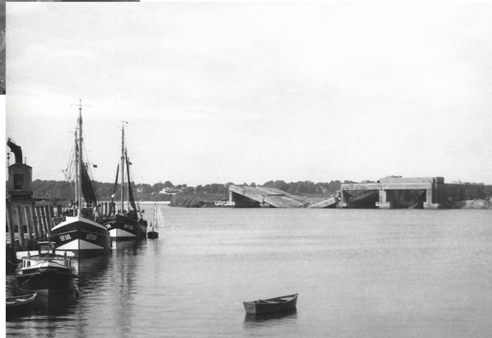
View from the Rüschkanal to the blown-up submarine bunker FINK II around 1950. (Peter Kaufner/ Finkenwerder Geschichtswerkstatt)
